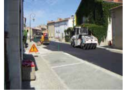
travaux sur la RD 623
